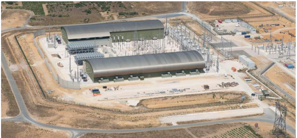
Estació conversora de Baixàs
