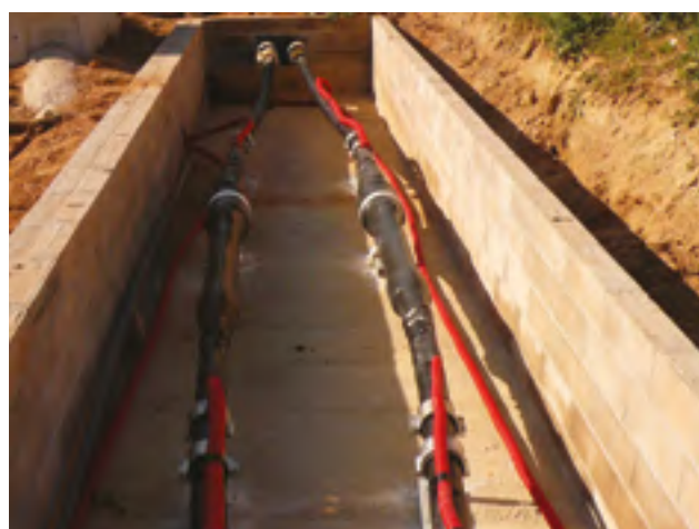
Figure 10 : Schéma et illustration de chambre de jonction
