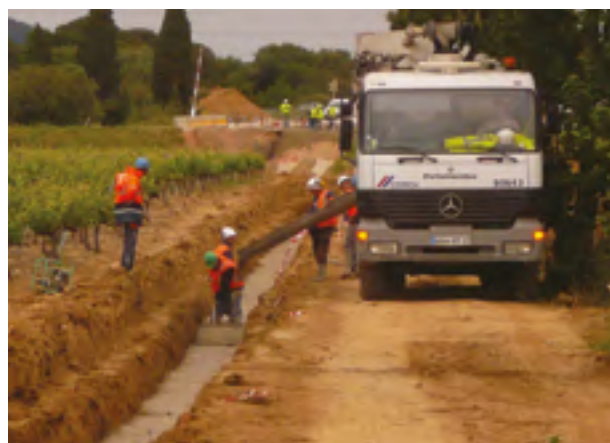
Figure 8 : Photos de la pose du génie civil de la liaison Baixas – Santa Llogaïa
