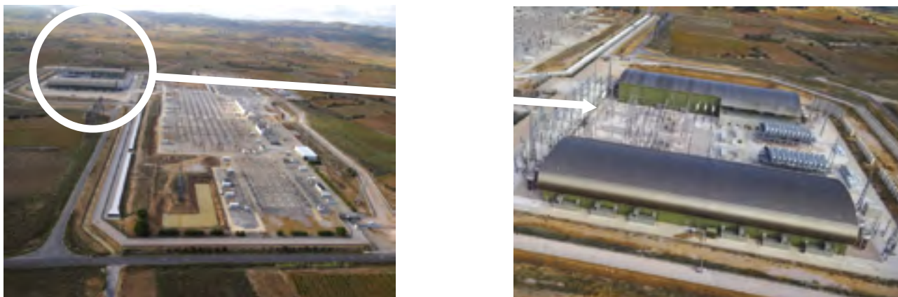
Figure 4 : Photos de la station de conversion existante de Baixas (proximité de Perpignan) à titre d'exemple
