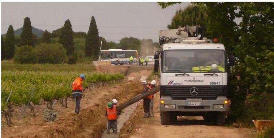
▲ La construction de la liaison entre la France et l'Espagne (côté Catalogne) qui est déjà en service. Une servitude sur une emprise de 2 mètres de part et d'autre de la tranchée est prévue.
