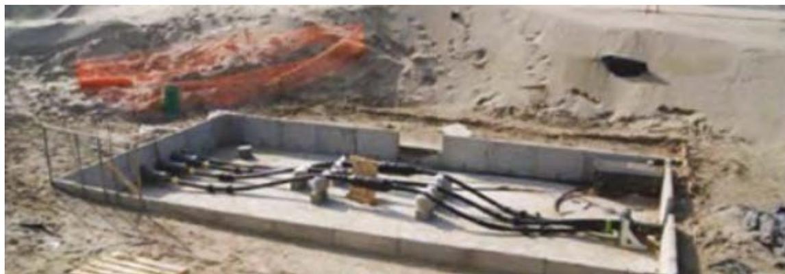
Figure 1: Exemple de chambre de jonction d'atterrage pour liaison alternative avant fermeture et remblayage
