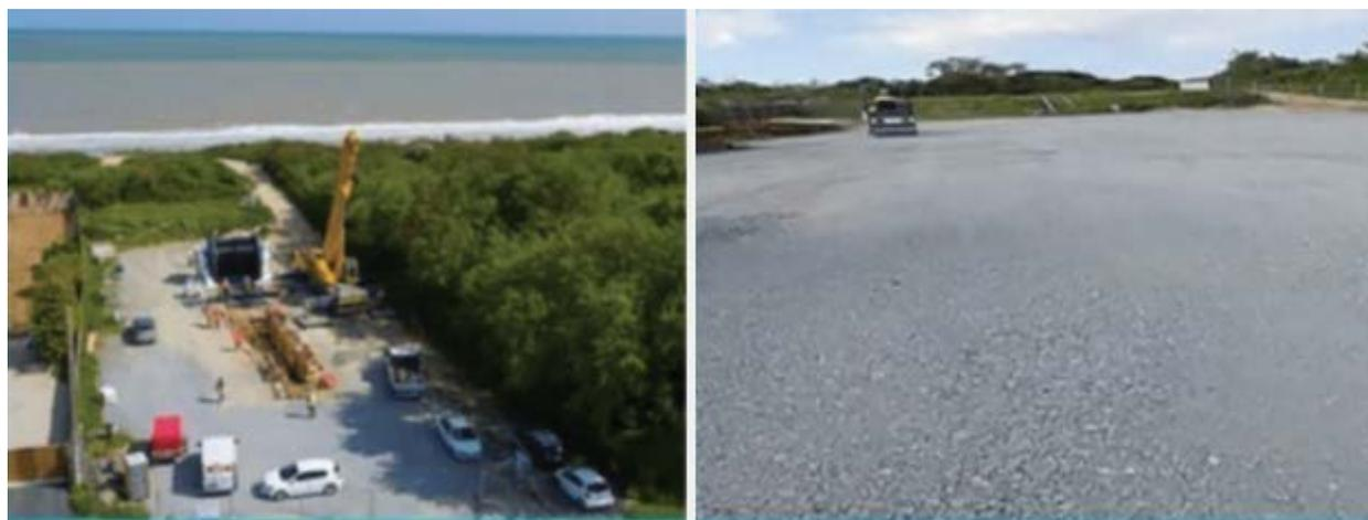
Exemple d'un chantier d'atterrage récent sur parking existant (IFA2) : chantier d'atterrage pendant travaux et parking remis en état après travaux
