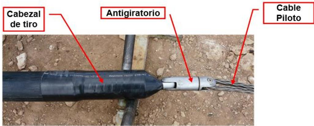
**Ilustración 17: Conexión entre cabezal de tiro y cable piloto**
